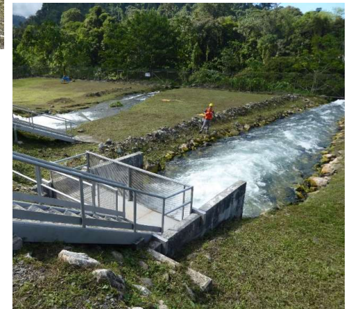
Fuites d'eau en pied de talus de la salle des machines (2015)
