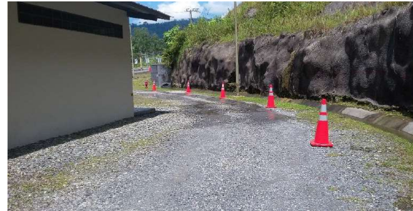
Fuites d'eau en pied de talus de la salle des machines (2015)
