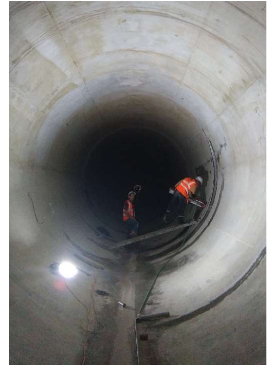
Revêtement en béton armé ou non-armé
