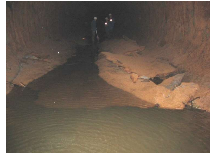
Dégradation galerie EDF Arc-Isère 1979
