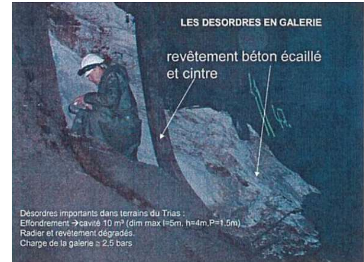
Dégradation galerie EDF Arc-Isère 1979
