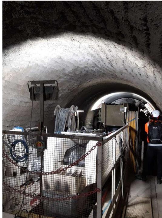
Soutènement définitif en béton projeté
