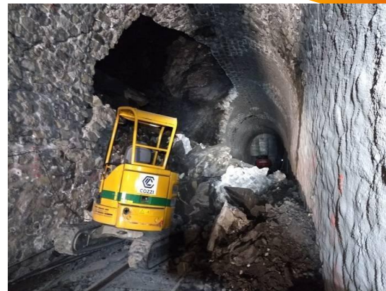
Effondrement lors de travaux dans le tunnel de Moriez (Chemins de fer de Provence) – février 2019 – 1 mort
