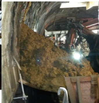
Venue importante de terrain sur le train travaux lors de travaux de création de raidisseurs dans le tunnel de Montmedy – juillet 2016
