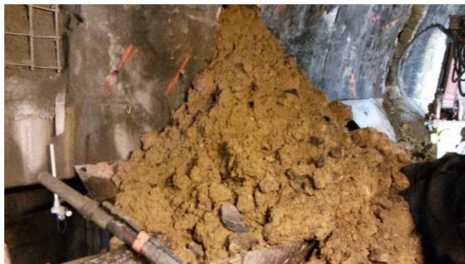
Venue importante de terrain sur le train travaux lors de travaux de création de raidisseurs dans le tunnel de Montmedy – juillet 2016
