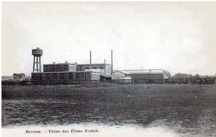
Fig. 18 : Photographie de l'usine Kodak (source : Wikipedia)
